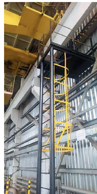
Оборудованные площадки для обслуживания кран-балки
