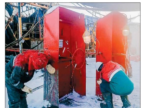
Члены бригады приводят бригадное оборудование в образцовый порядок. / ФОТО ИЗ АРХИВА БРИГАДЫ.
