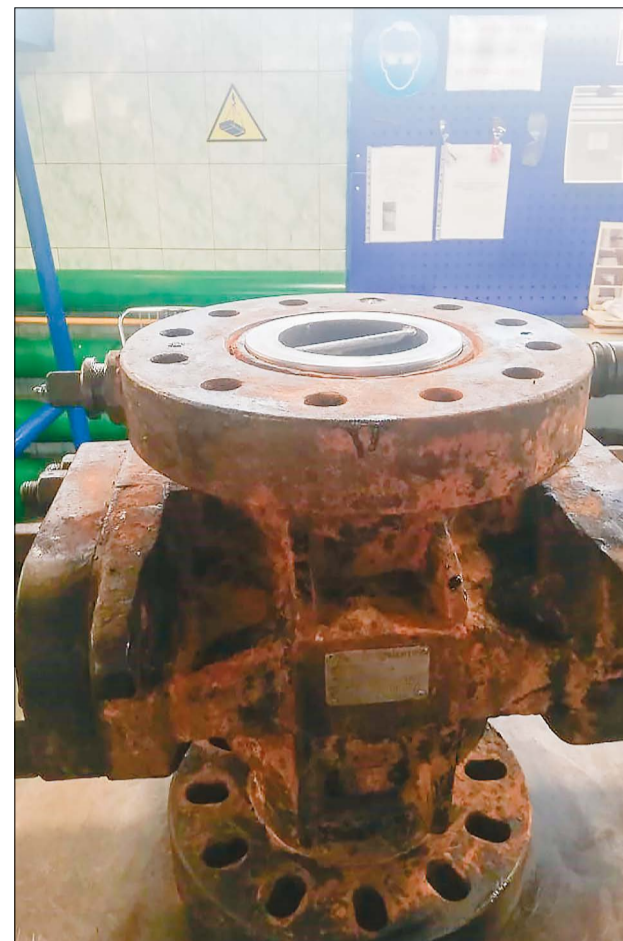
Контроль состояния конуса превентора с помощью шаблона. / ФОТО: ИЛЬНУР ДАВЛЕТШИН.
