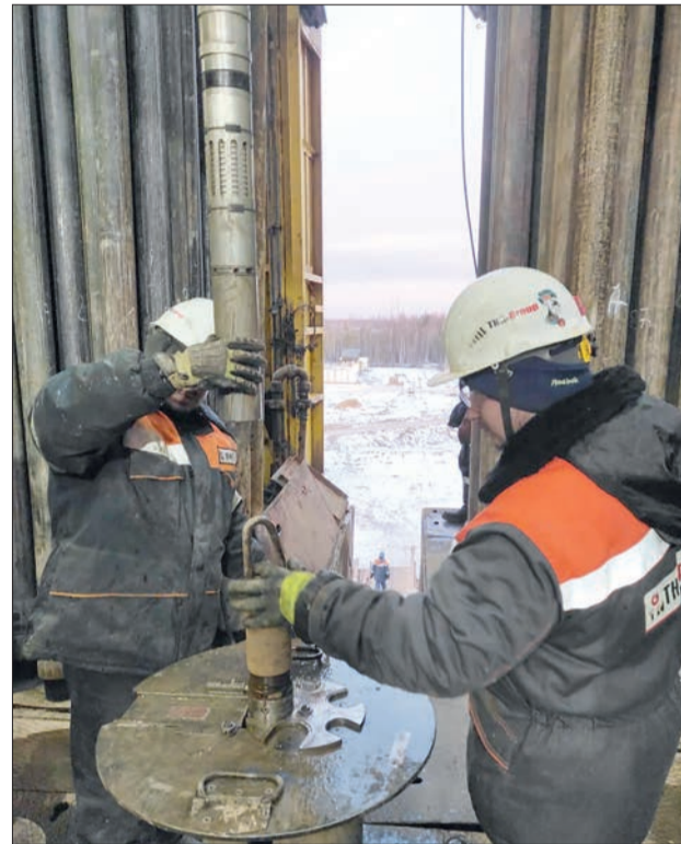
Работы на скважине
