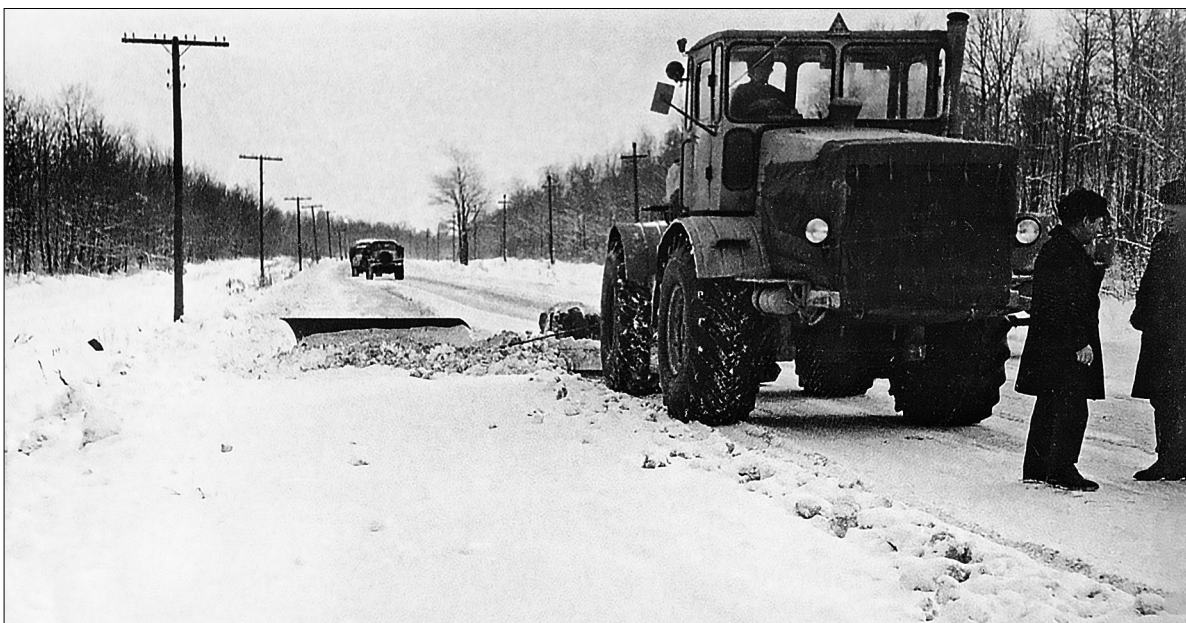
Автодорога Заинск — Набережные Челны. Бетькинский участок. 1972 год
