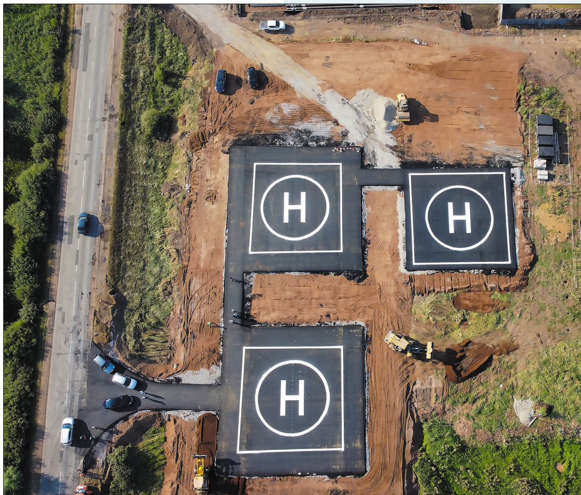
Построенные вертолетные площадки
