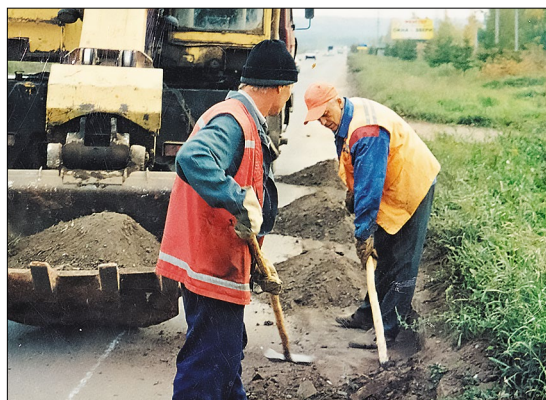
Расширение обочины дороги
