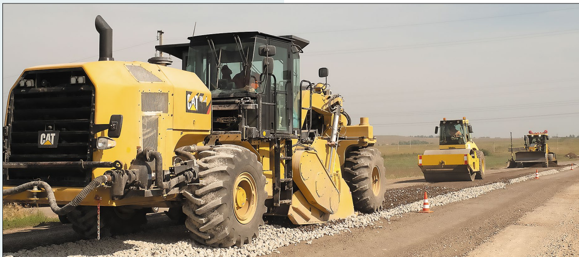
Дорожное строительство. 2020 год
