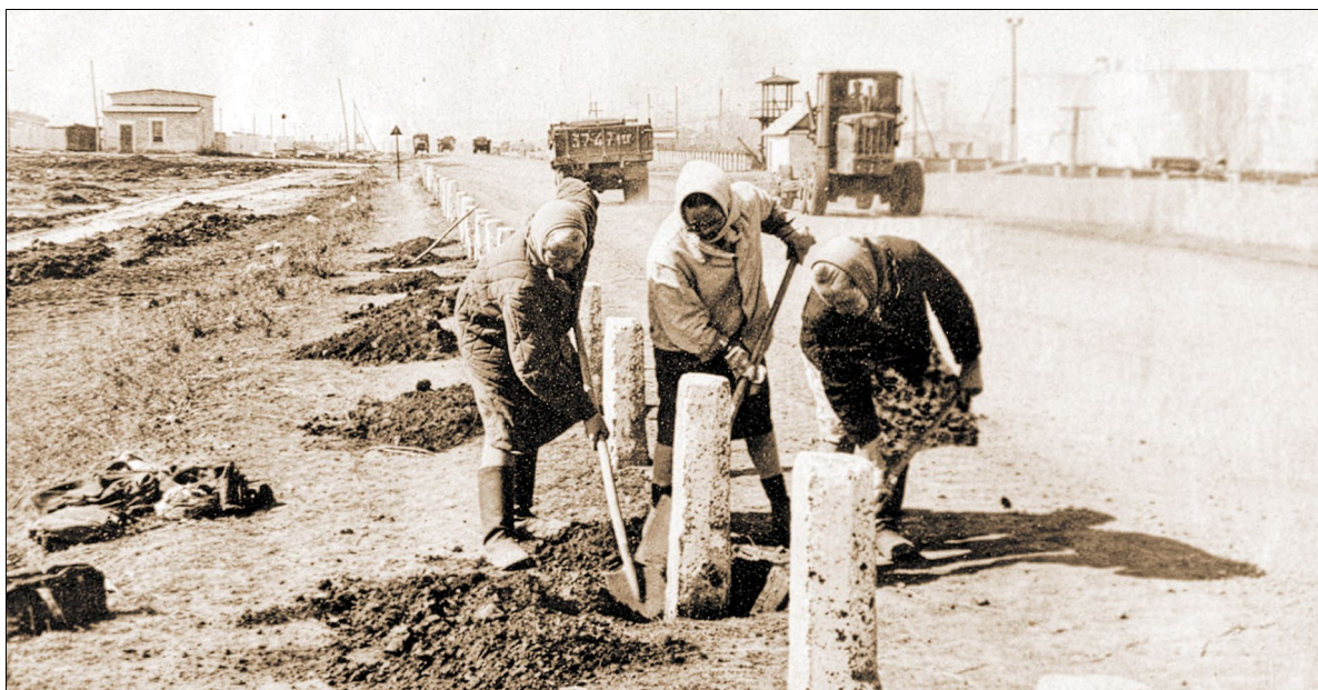
Первопроходцы дорожной службы нефтяников. Закладка бетонных сигнальных столбиков
