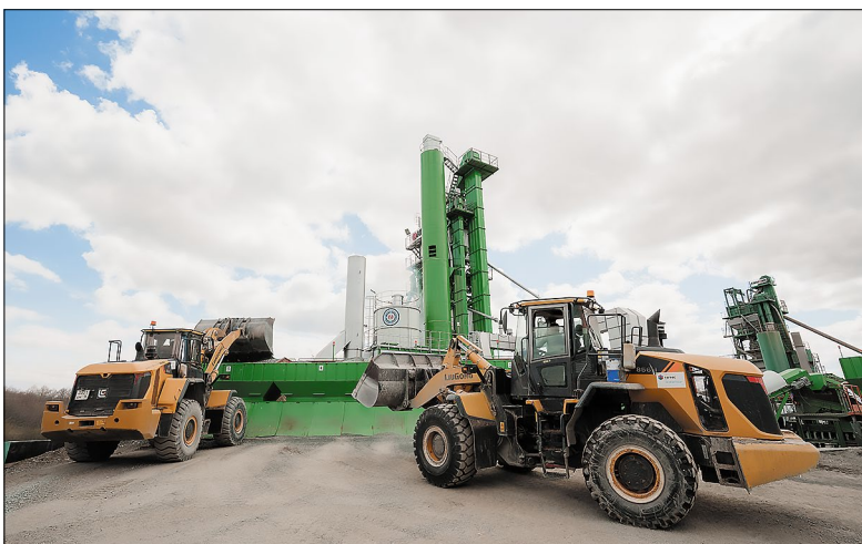
Процесс загрузки инертных материалов в дозаторы асфальтосмесительной установки
