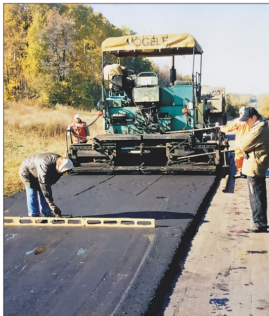
Укладка по уровню — работа на уровне
