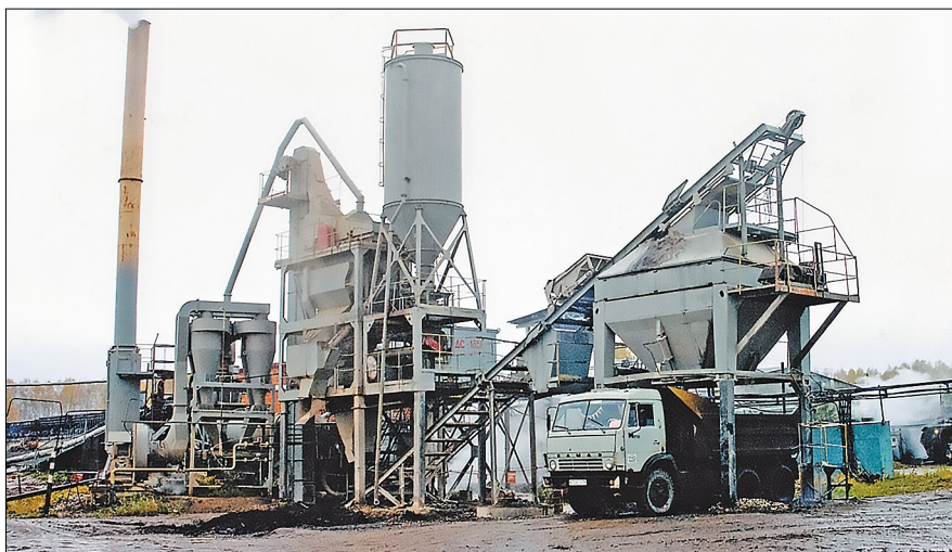
Асфальтобетонный завод на станции Акташ, оснащенный смесителями Тельтомат, ДС-158, ДС-1858
