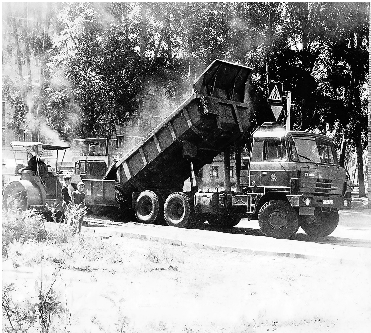
Дорожные работы в Альметьевске
