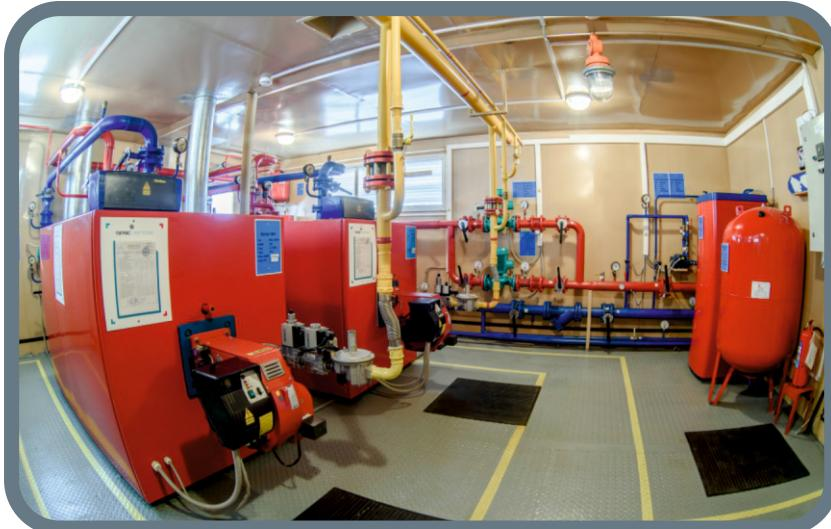
Блочно-модульные котельные производства ООО «ТаграС-ЭнергоСервис» мощностью от 0,1 МВт до 40 МВт представляют собой полностью готовые к эксплуатации модули, в полной заводской готовности, в которых смонтировано: технологическое оборудование, автоматика безопасности, электрооборудование, водоподготовительная установка, приборы автоматического регулирования, контроля, сигнализации и управления технологическими процессами. Количество модулей котельной зависит от её мощности.
