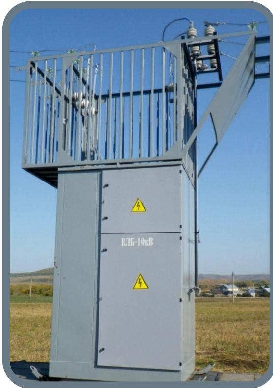
ВЛБ предназначен для выполнения секционирования, защиты и коммутаций в распределительных сетях трехфазного переменного тока частотой 50 Гц с номинальным напряжением 6 (10) кВ, а также для подключения высоковольтных электроприемников, концевых подстанций.
