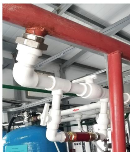
ром котельной Мансуровой Рузили было предложено произвести монтаж установки по магнитной обработке воды. При воздействии на воду постоянным магнитным полем ионы кальция, кремния и магния теряют свою способность к солеобразованию на поверхностях водоподготовительной установки.
