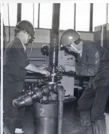
Монтаж УЭЦН на испытательном стенде, цех №2
