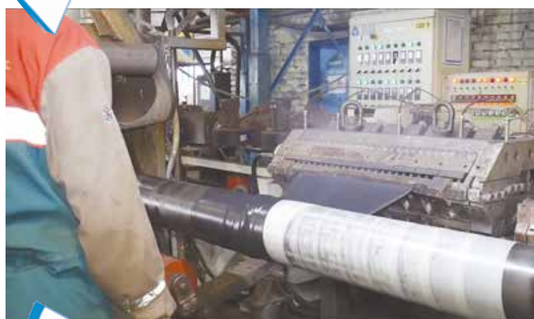
ЭТАП 3. Идет подготовка и нанесение изолирующего покрытия
