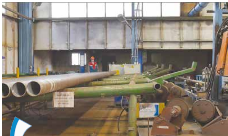
ЭТАП 1. Стальные и полиэтиленовые трубы и материалы проходят входной контроль
