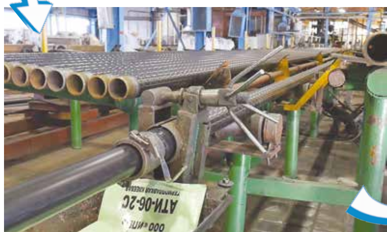
ЭТАП 4. Стальную трубу футеруют полиэтиленовыми трубами и заземляют концы
