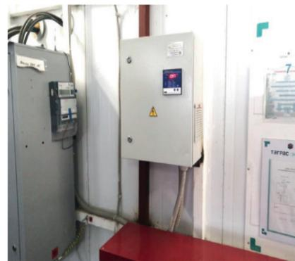
лирование реактивной мощности. В результате КРМ снижает нецелевые расходы электроэнергии и продлевает срок службы (эксплуатации) вспомогательного оборудования котельной измеряя и поддерживая величину  $\cos \phi$  на заданном оптимальном уровне путём выдачи команд на исполнительные устройства без участия персонала.
